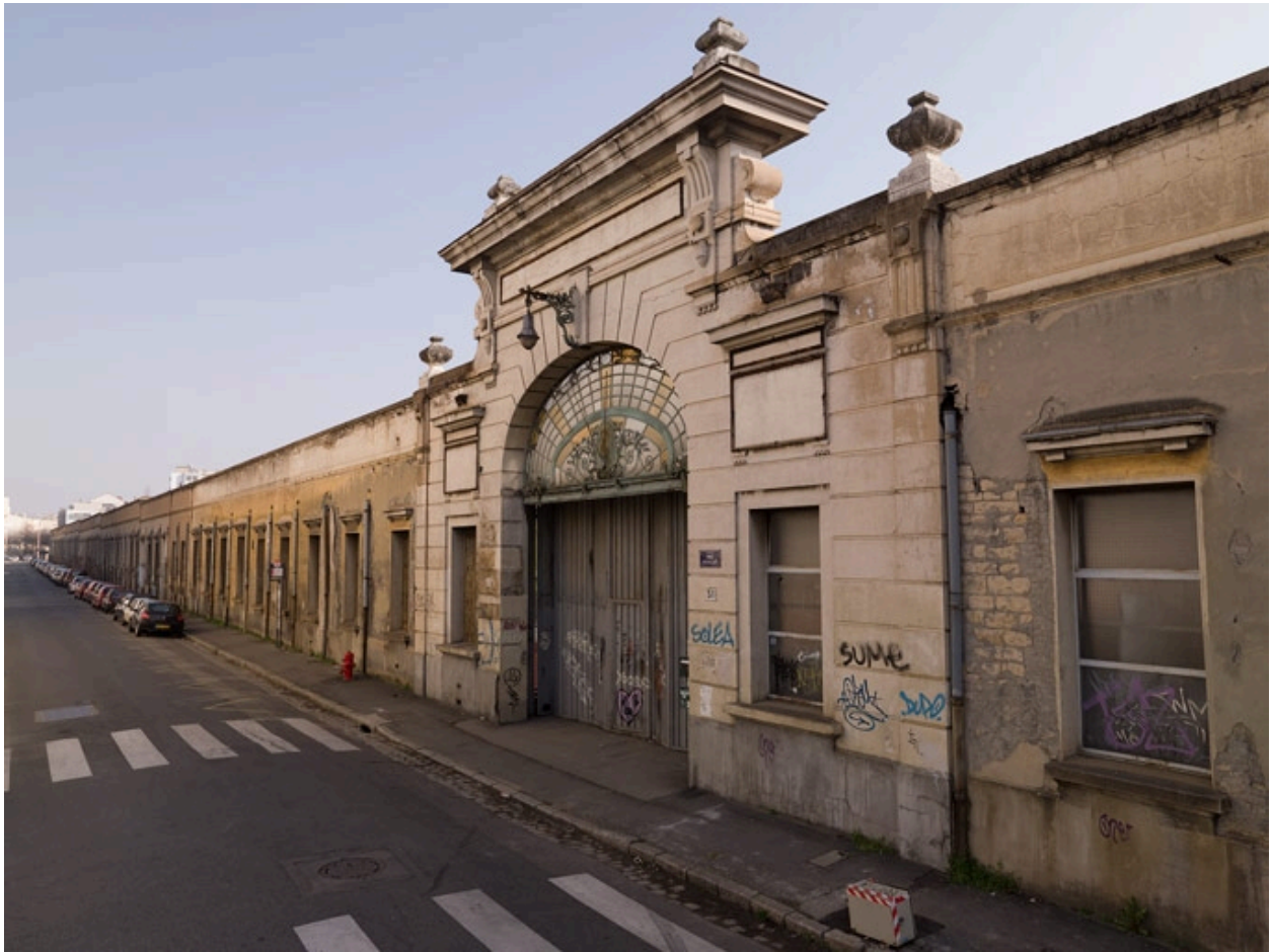
Façade Feuillat et entrée monumentale
