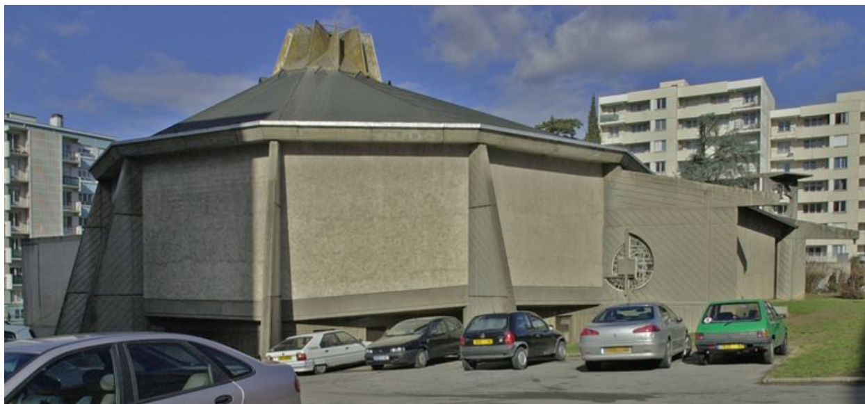
Vue du chevet depuis le sud-est
