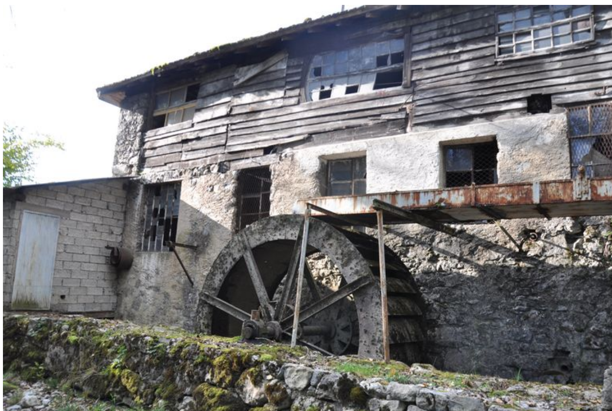
Détail de la roue à augets animant la taillanderie
