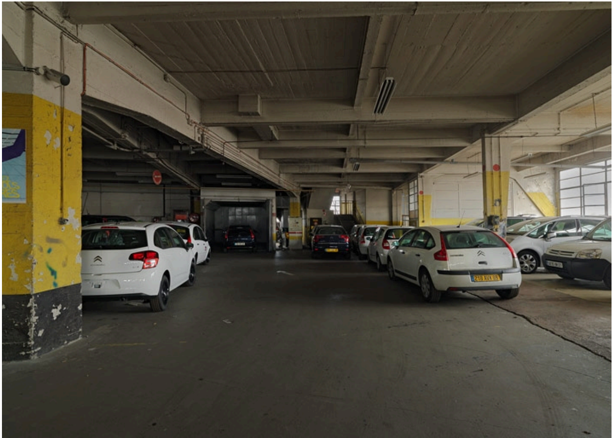
Vue d'ensemble du 4e étage, détail cabine technique
