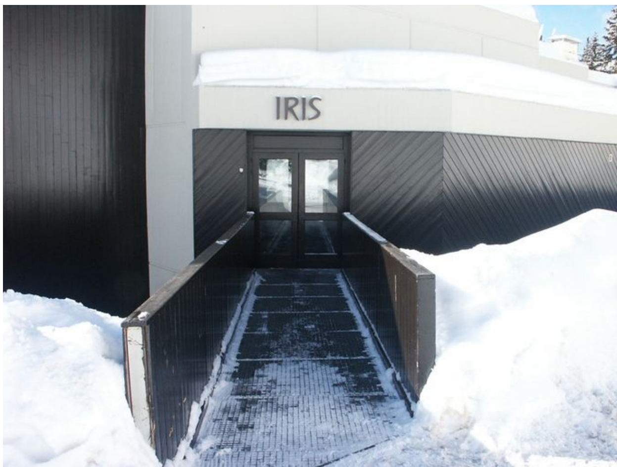
La passerelle d'entrée de la résidence
