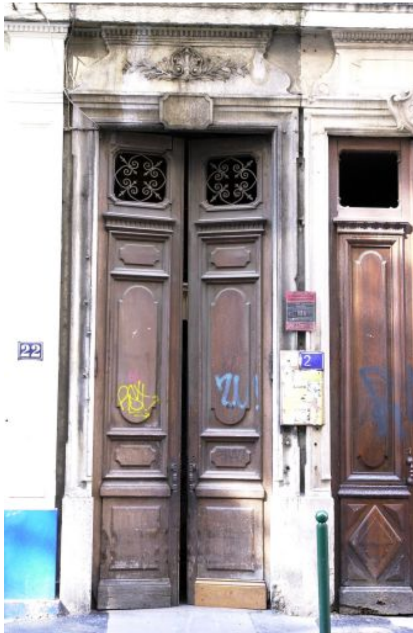
Façade rue Longue, porte de l'allée secondaire
