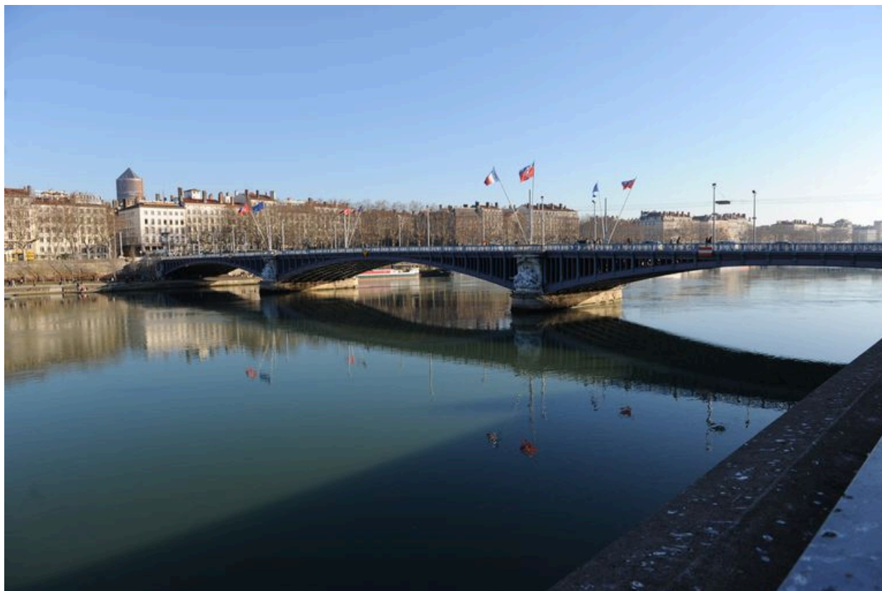
Vue générale, face amont (depuis la rive droite)
