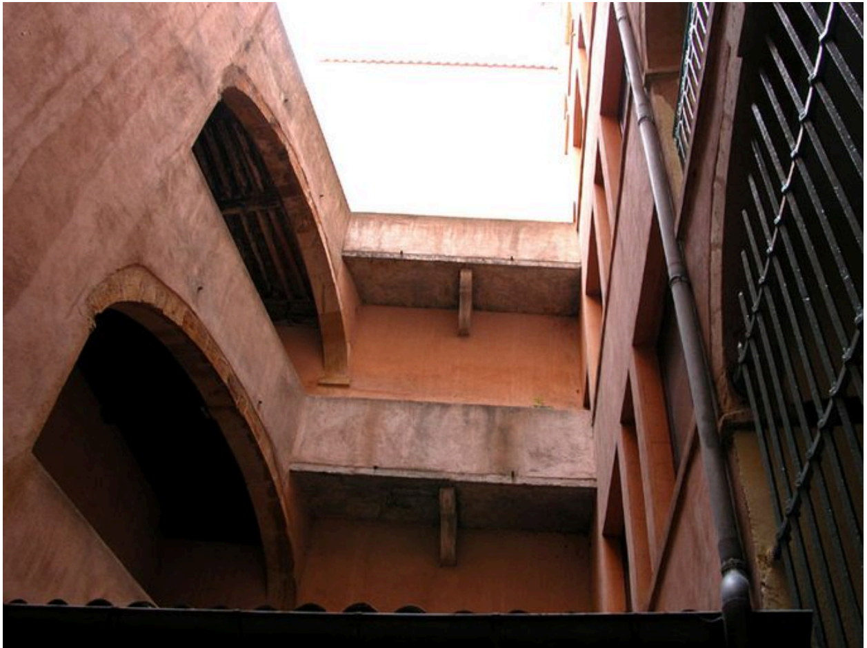
Les galeries, côté nord et ouest de la cour
