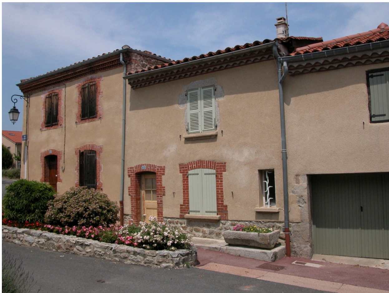
Faubourg de la Sablière. Maison (1999 AB 138, rue de l'Arzalier).
