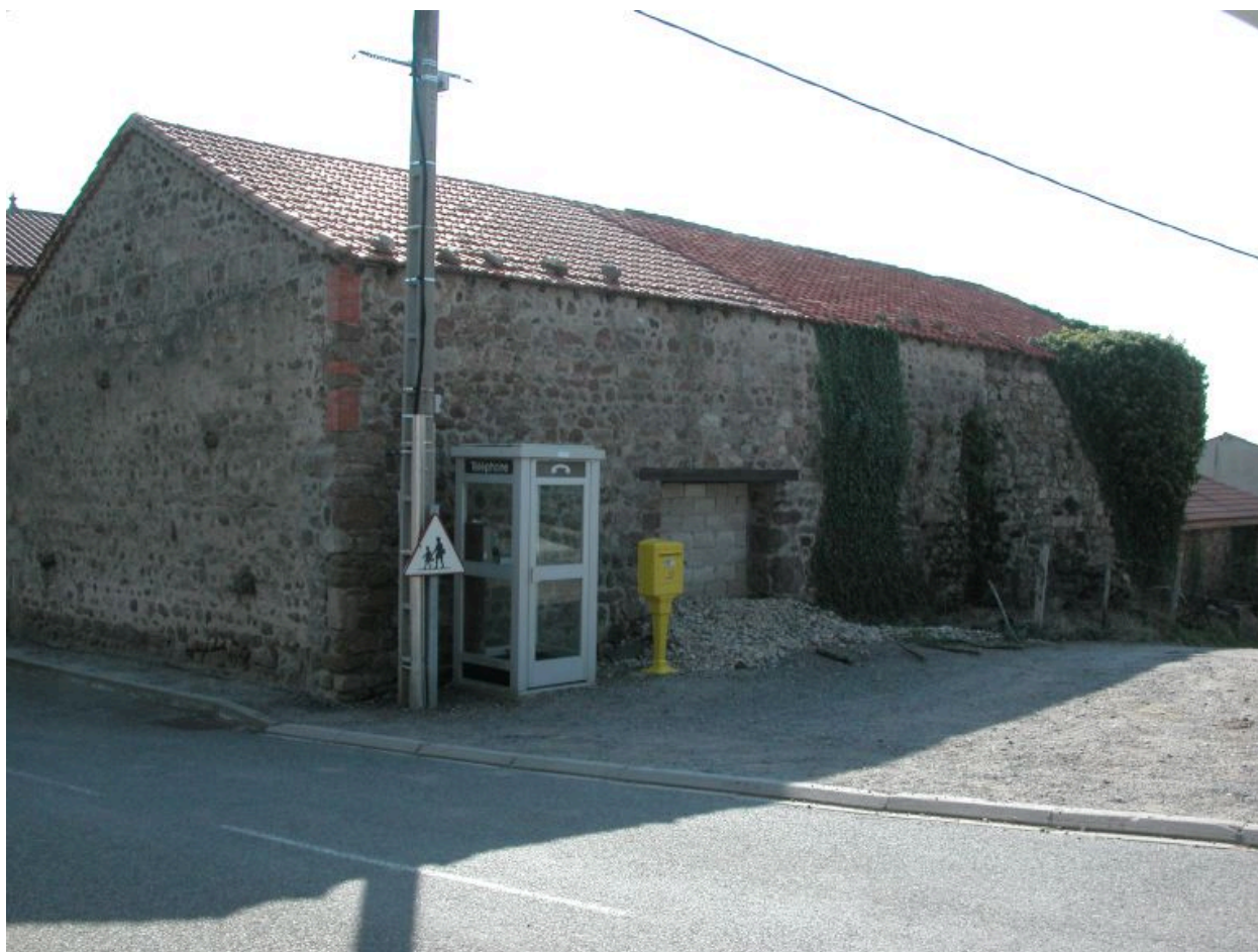
Elévation arrière des communs de la ferme.
