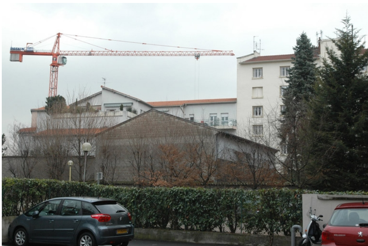
Entrepôt vitrerie, vue générale sud ouest
