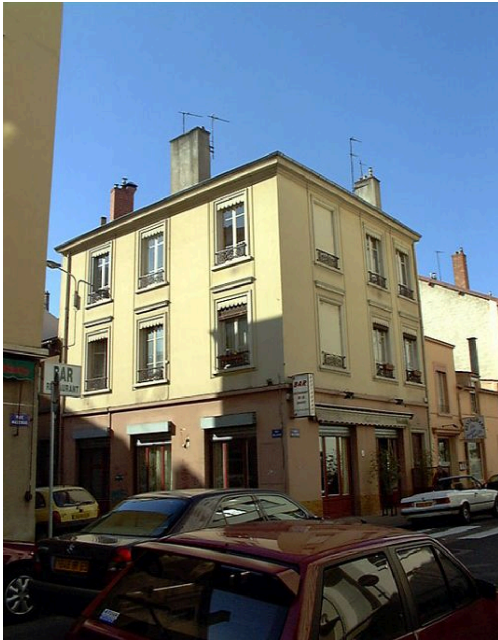
Vue générale des façades sur rue
