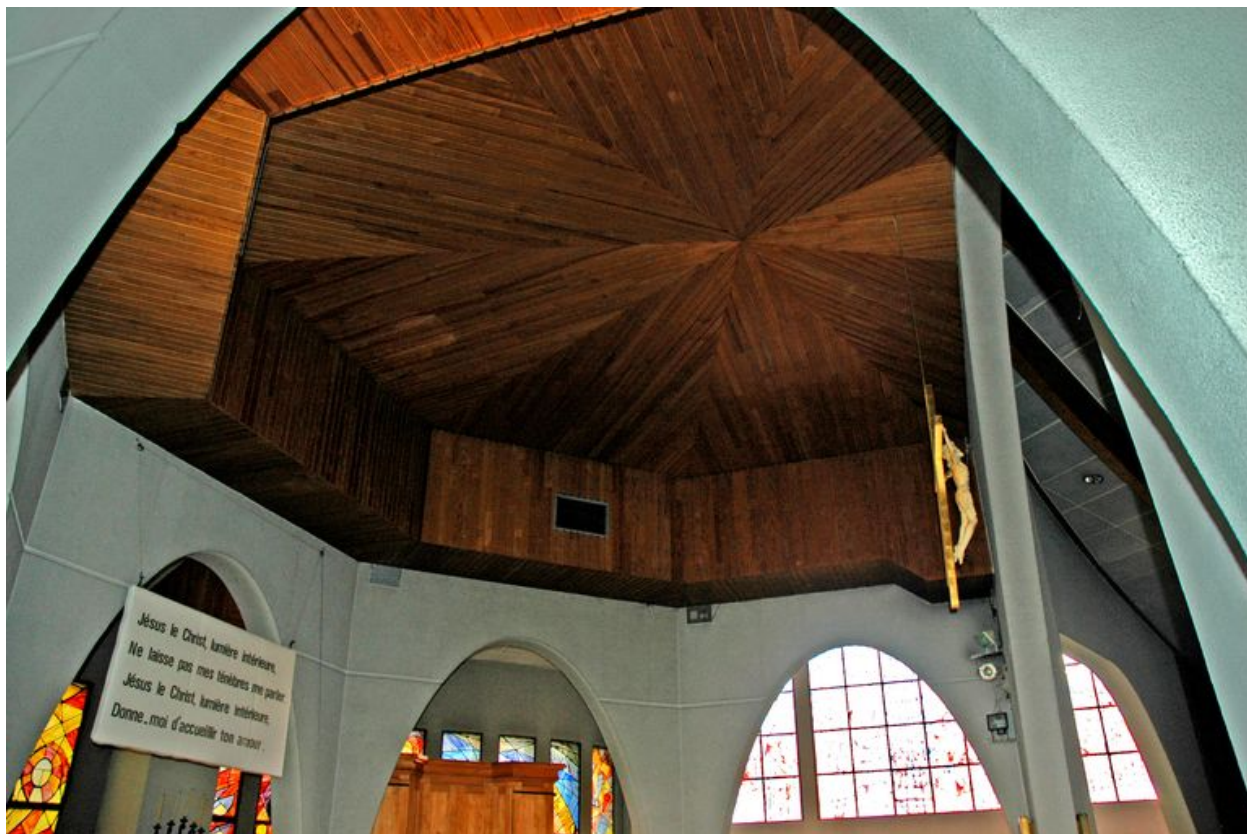
Le couvrement du chœur depuis le nord
