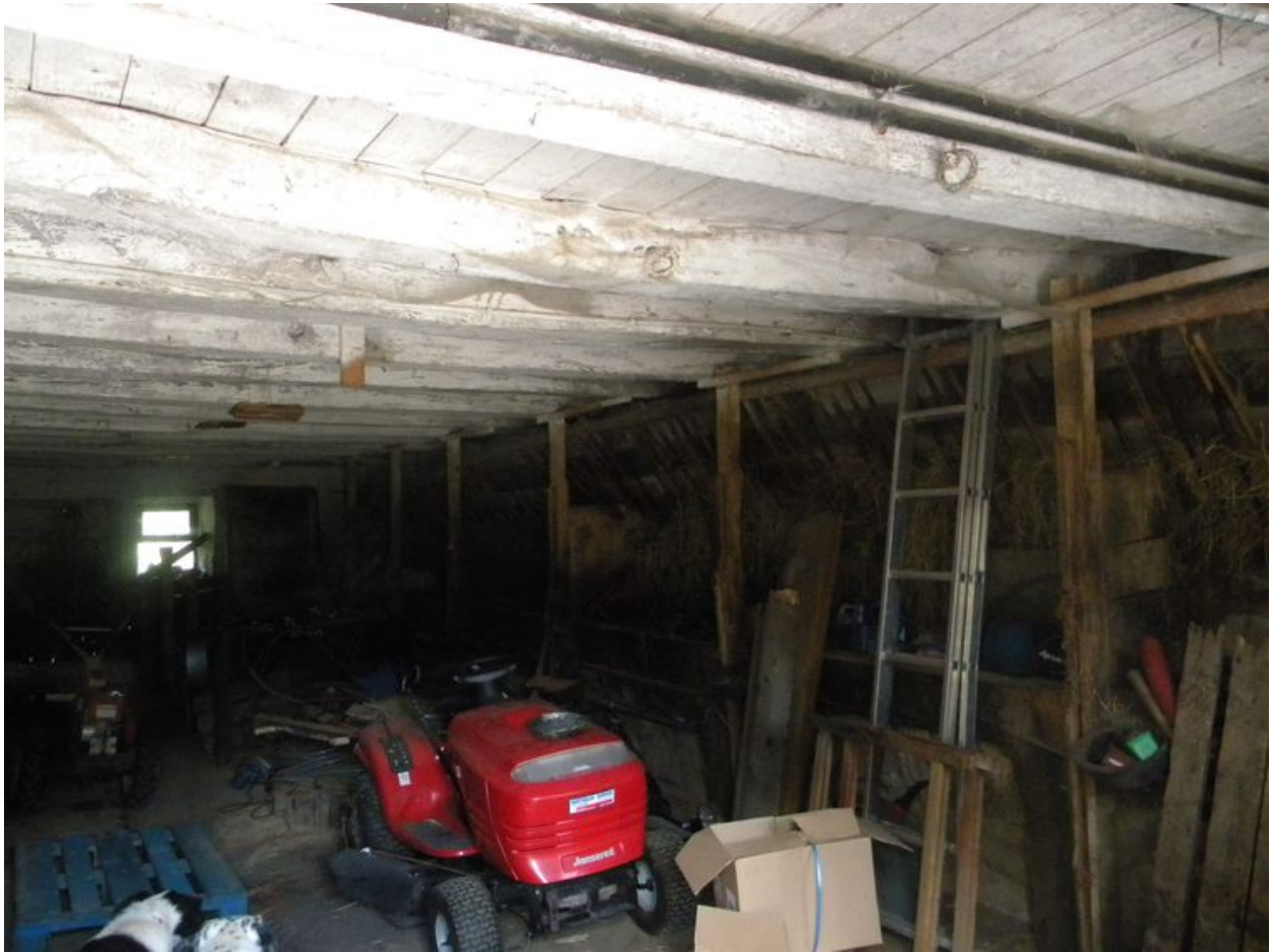
Vue de l'ancienne étable
