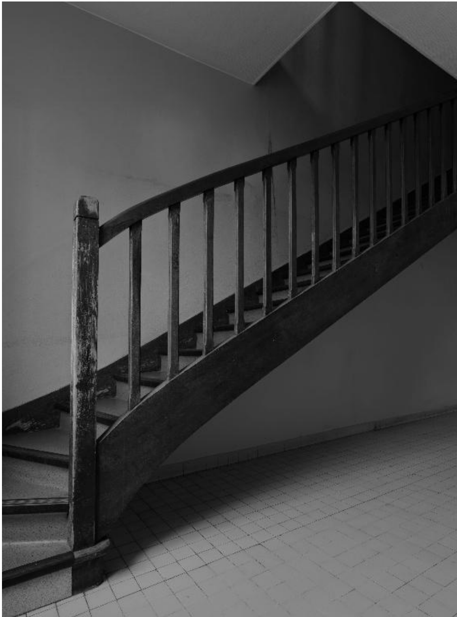
Corps de bâtiment principal, escalier menant au comble
