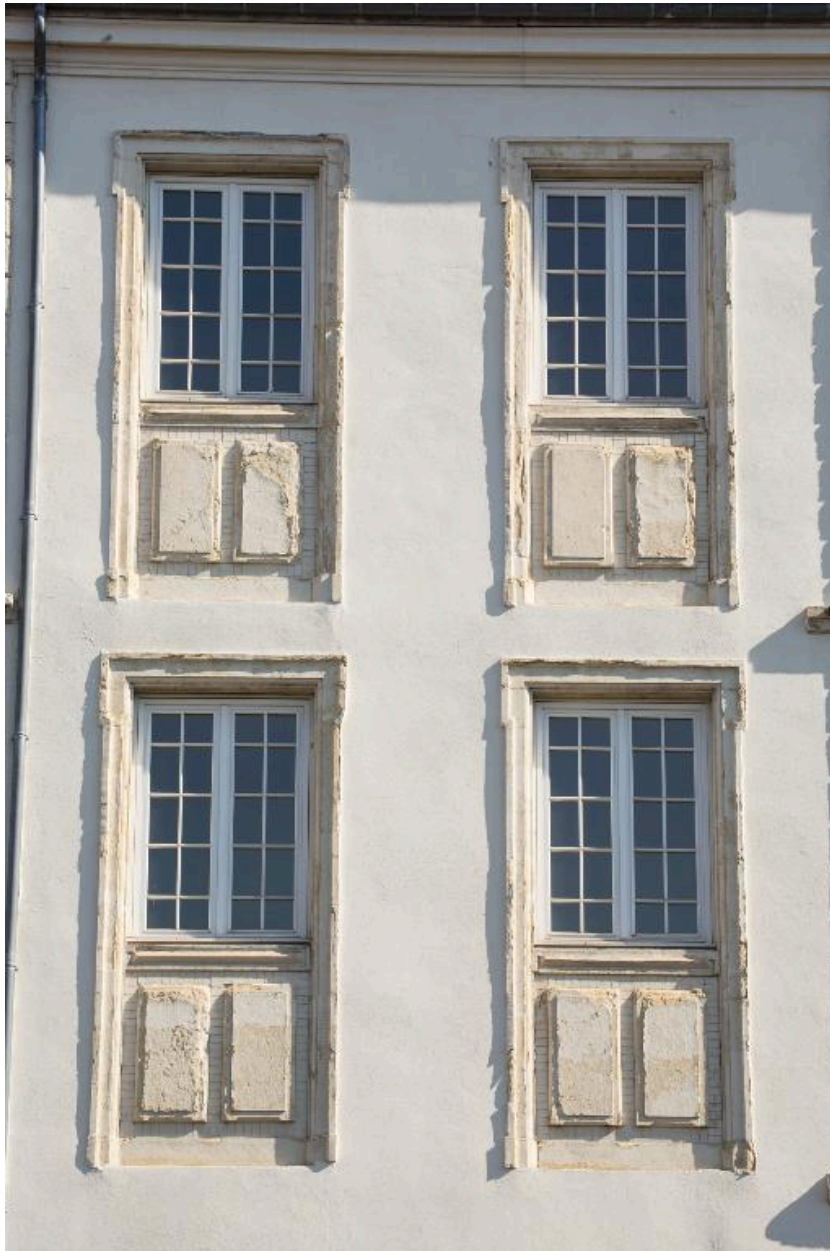
Bâtiment H, fenêtres sur cour
