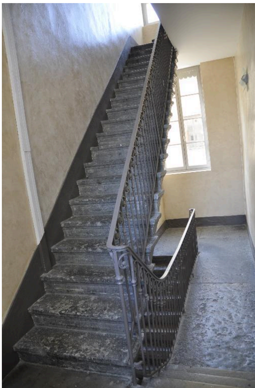
Vue de l'escalier depuis le palier
