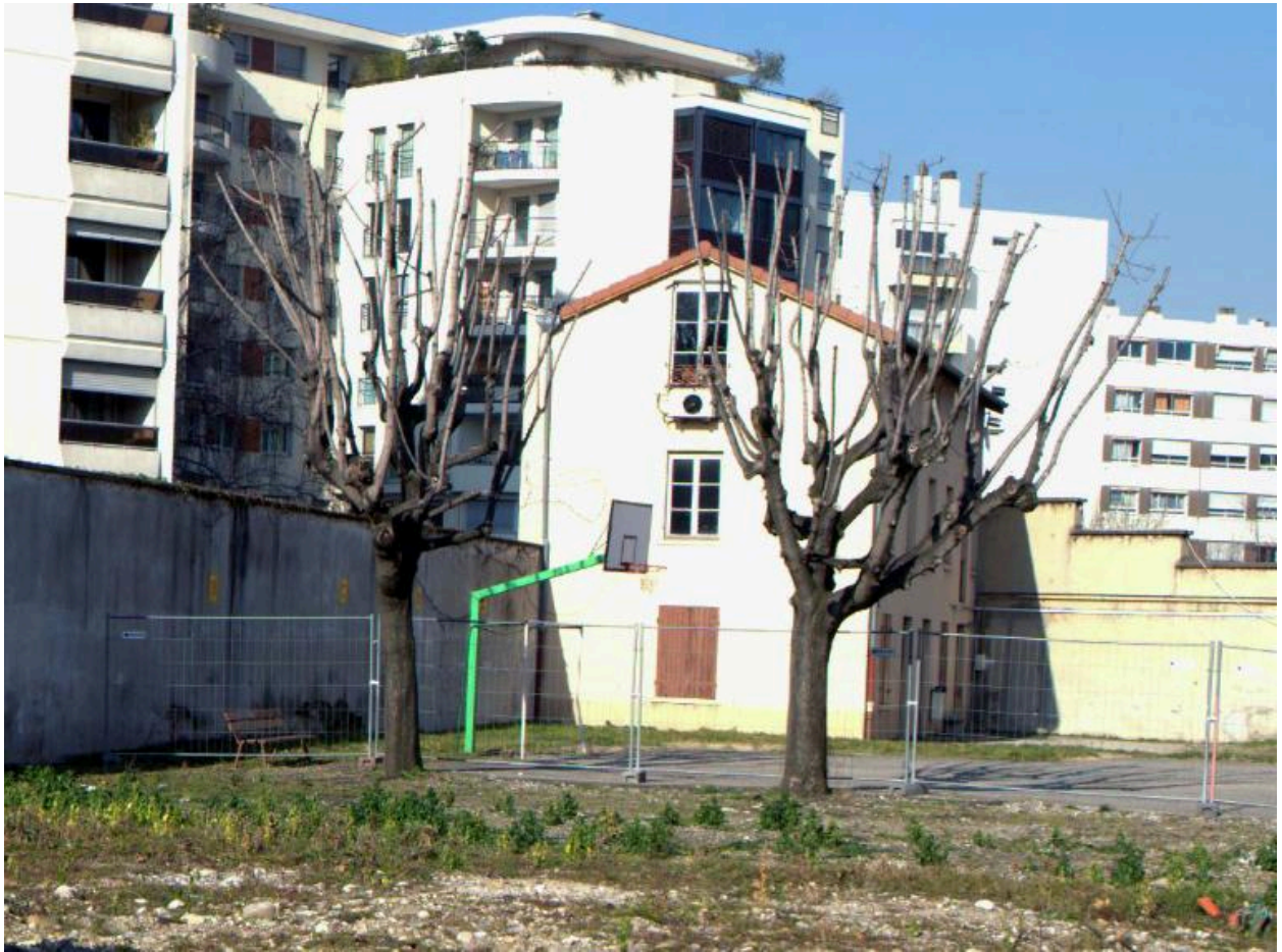
Bâtiment D, vu depuis l'est
