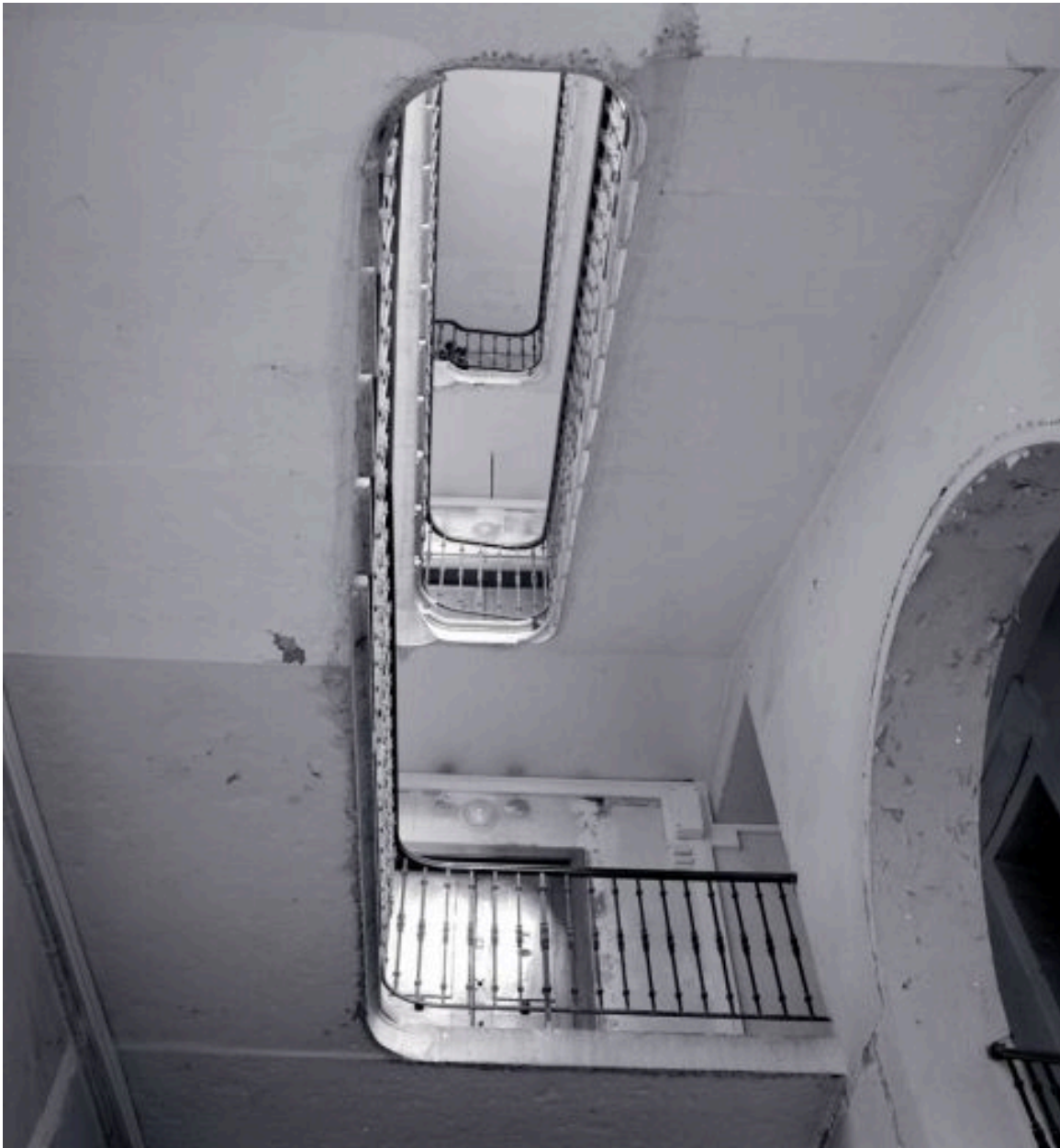
Vue de la cage d'escalier depuis le bas
