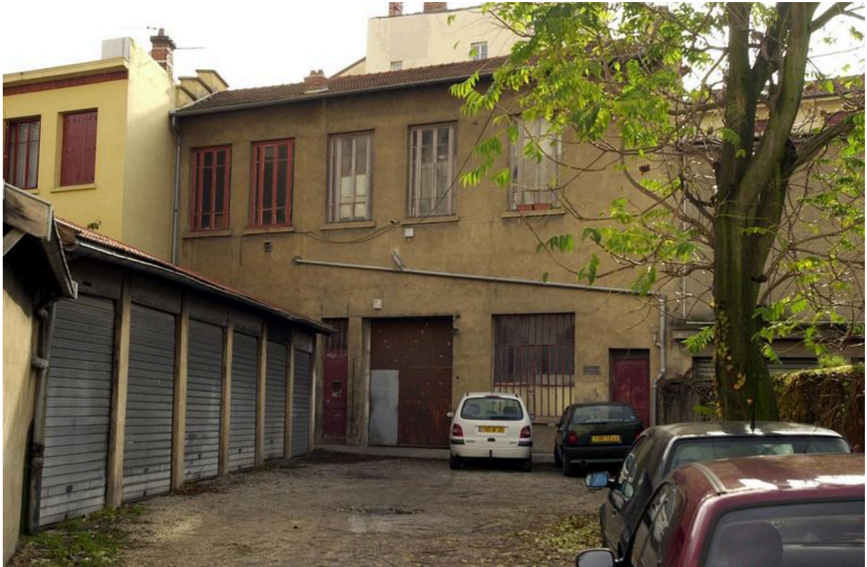
Atelier, vue d'ensemble côté cour
