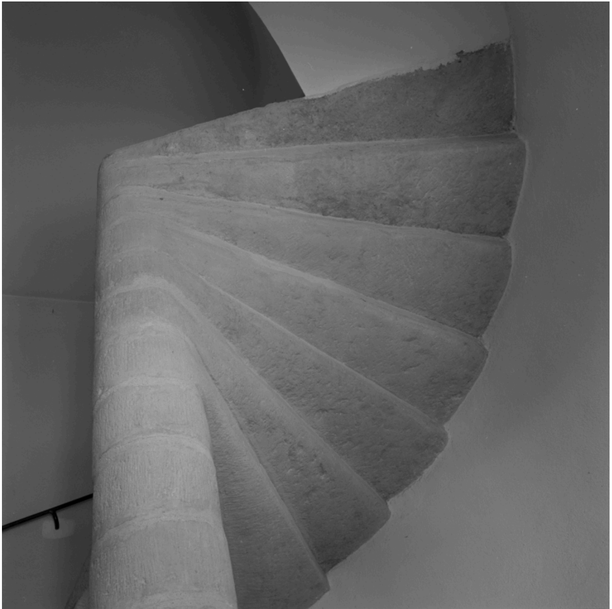
Arrivée de l'escalier en vis.
