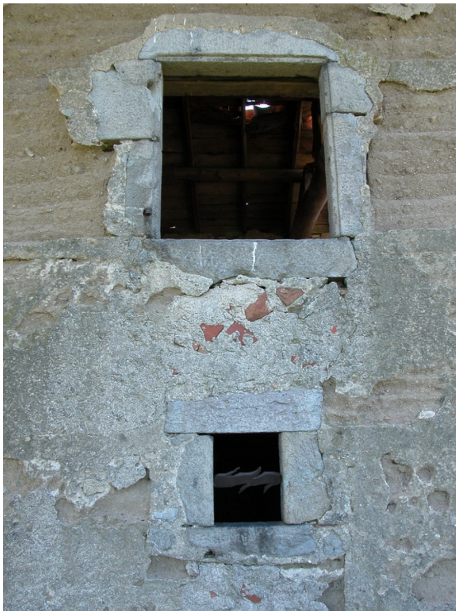
Détail des ouvertures sur le mur gouttereau.
