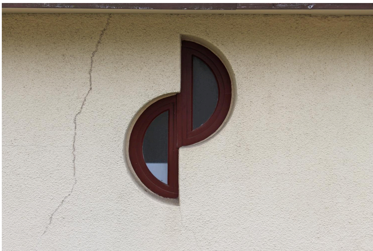
Aulnat, la Maison B.-C., détail d'une fenêtre en façade principale.
