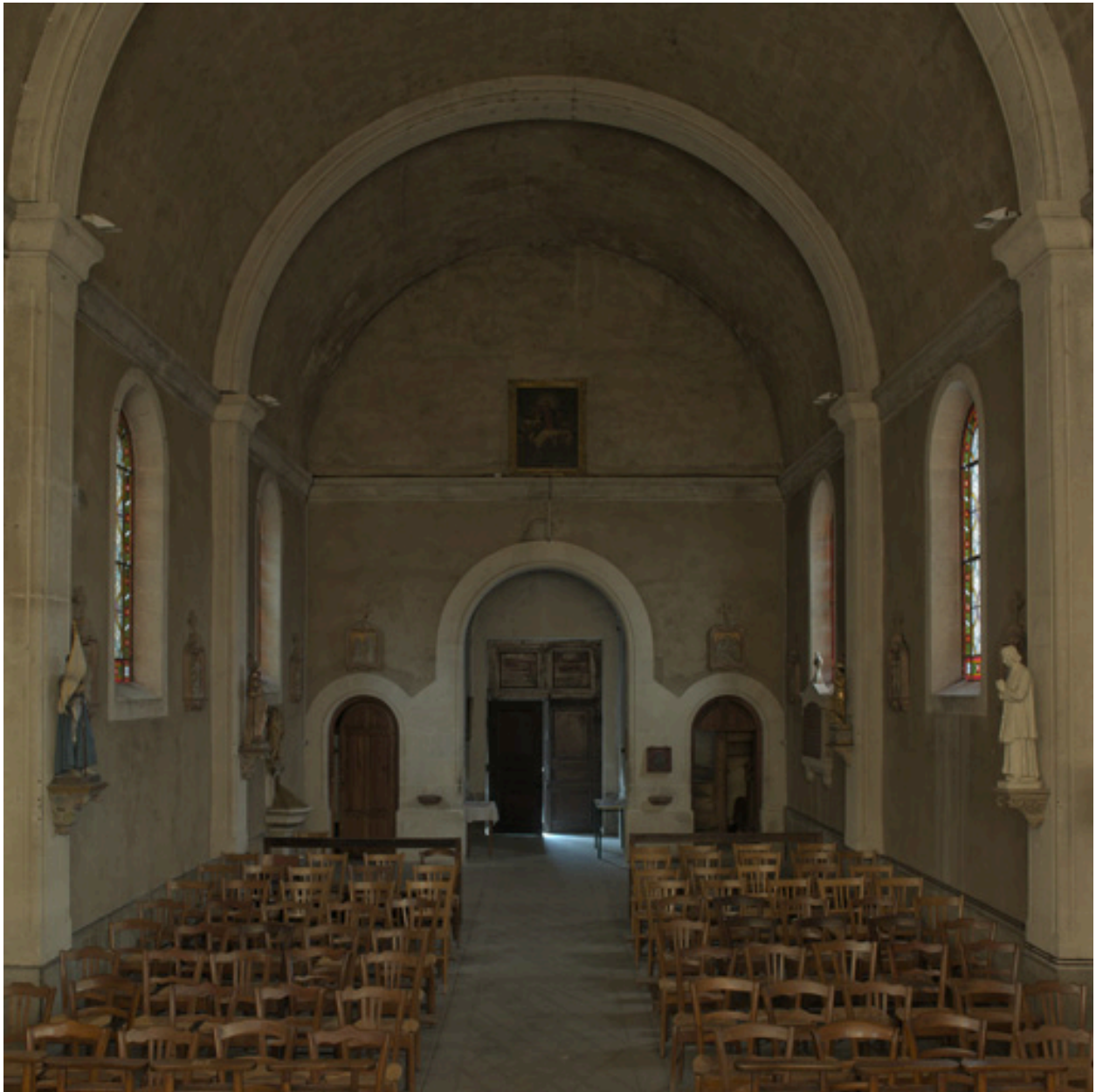
Vue d'ensemble intérieure en direction de l'entrée.
