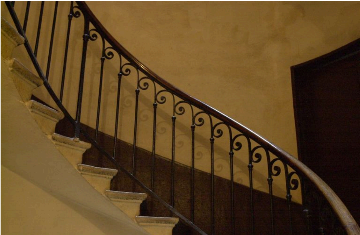
Détail de la rampe d'escalier
