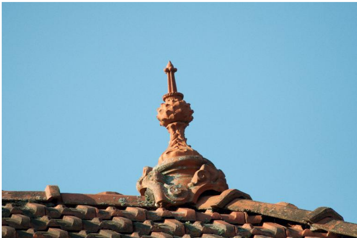
Détail d'un épi de faîtage
