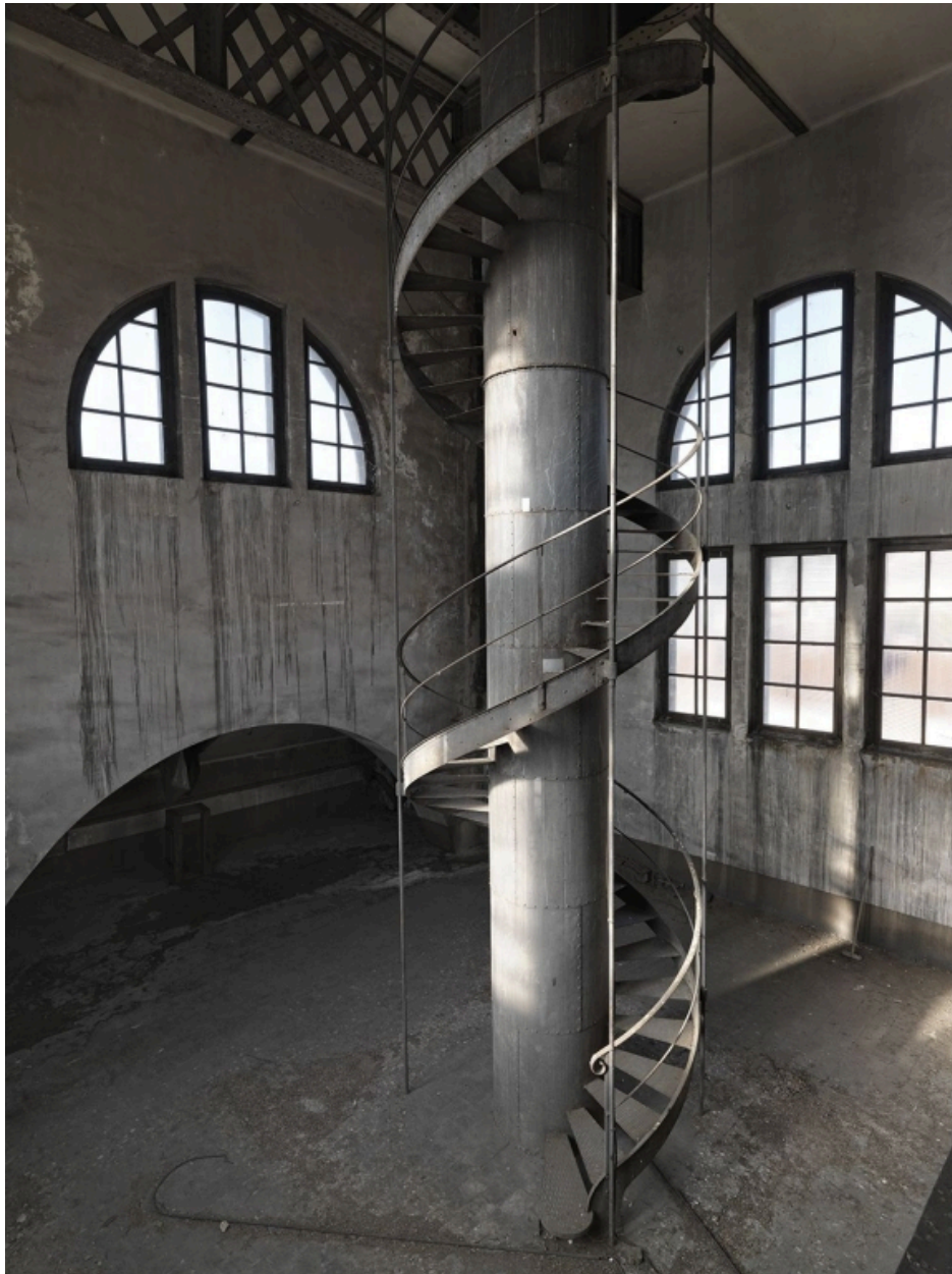
Le dôme Pascalon. Escalier métallique d'accès au lanternon
