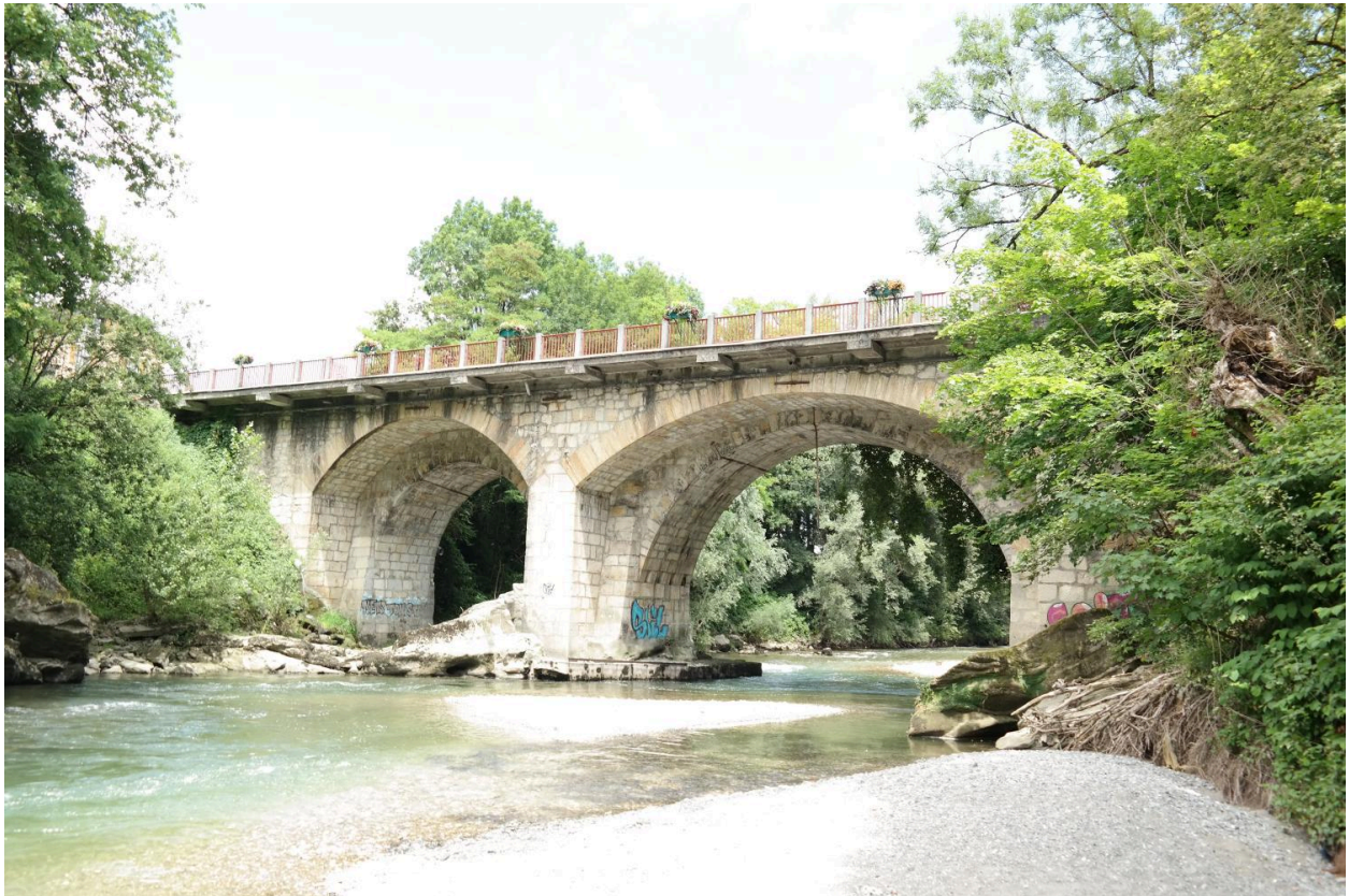
Pont de Tassets, vue de la face aval
