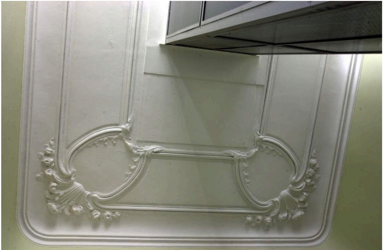
Plafond de la cage de l'escalier principal, moitié nord
