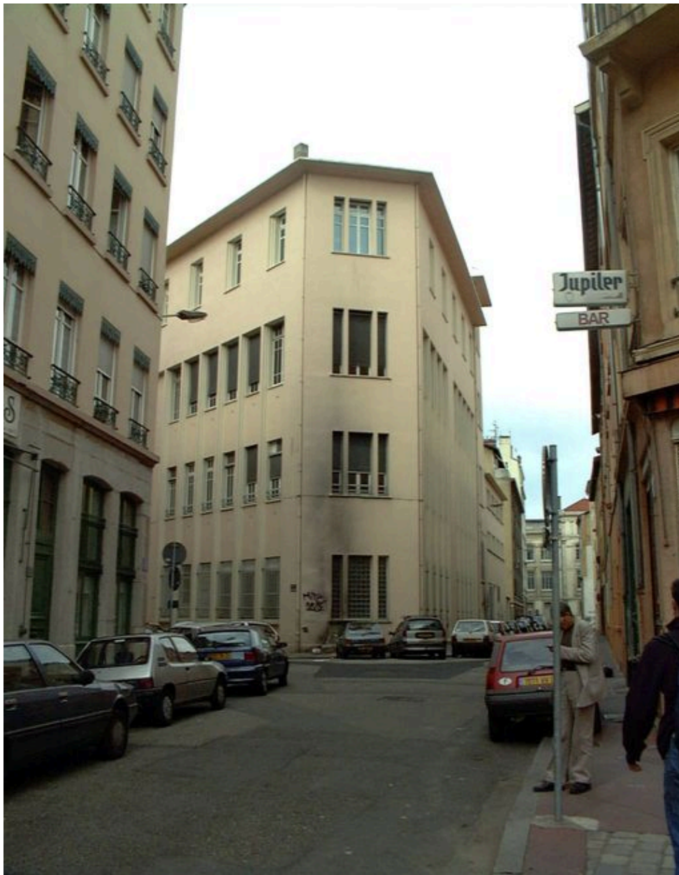
Vue du pan coupé, angle rue Edison / Vaudrey
