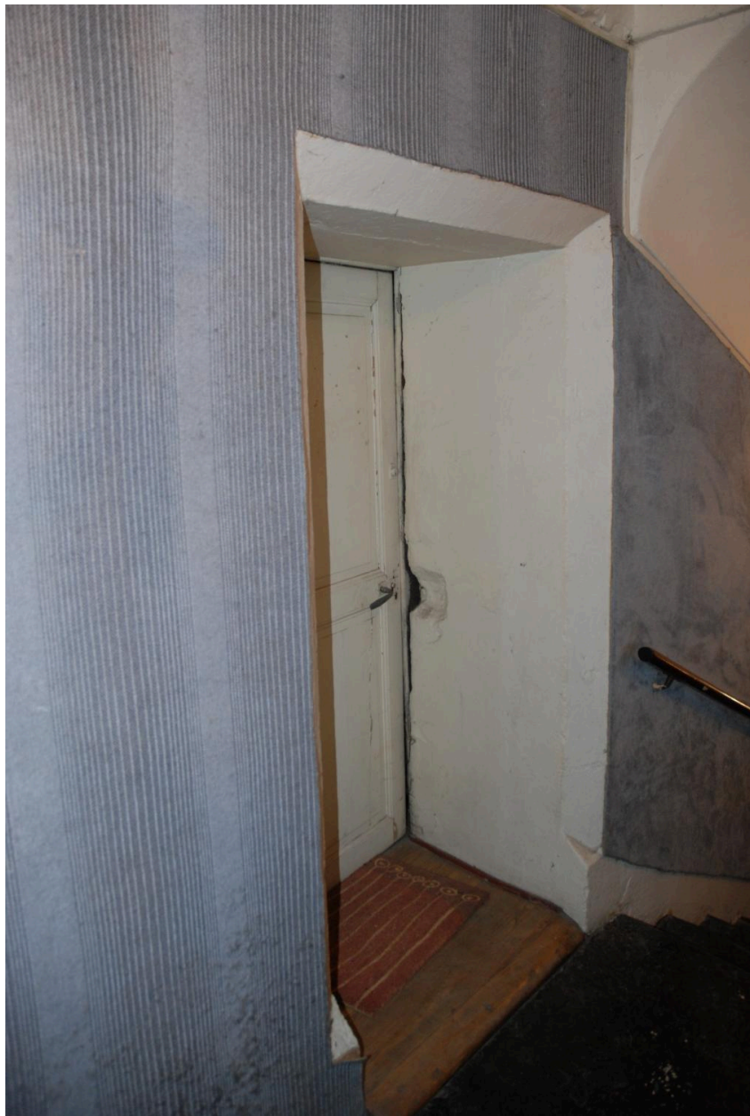
Vue intérieure : détail de la porte à l'extrémité de l'escalier d'accès au rez-de-chaussée surélevé (mur très épais, encadrement à chanfreins et congés).
