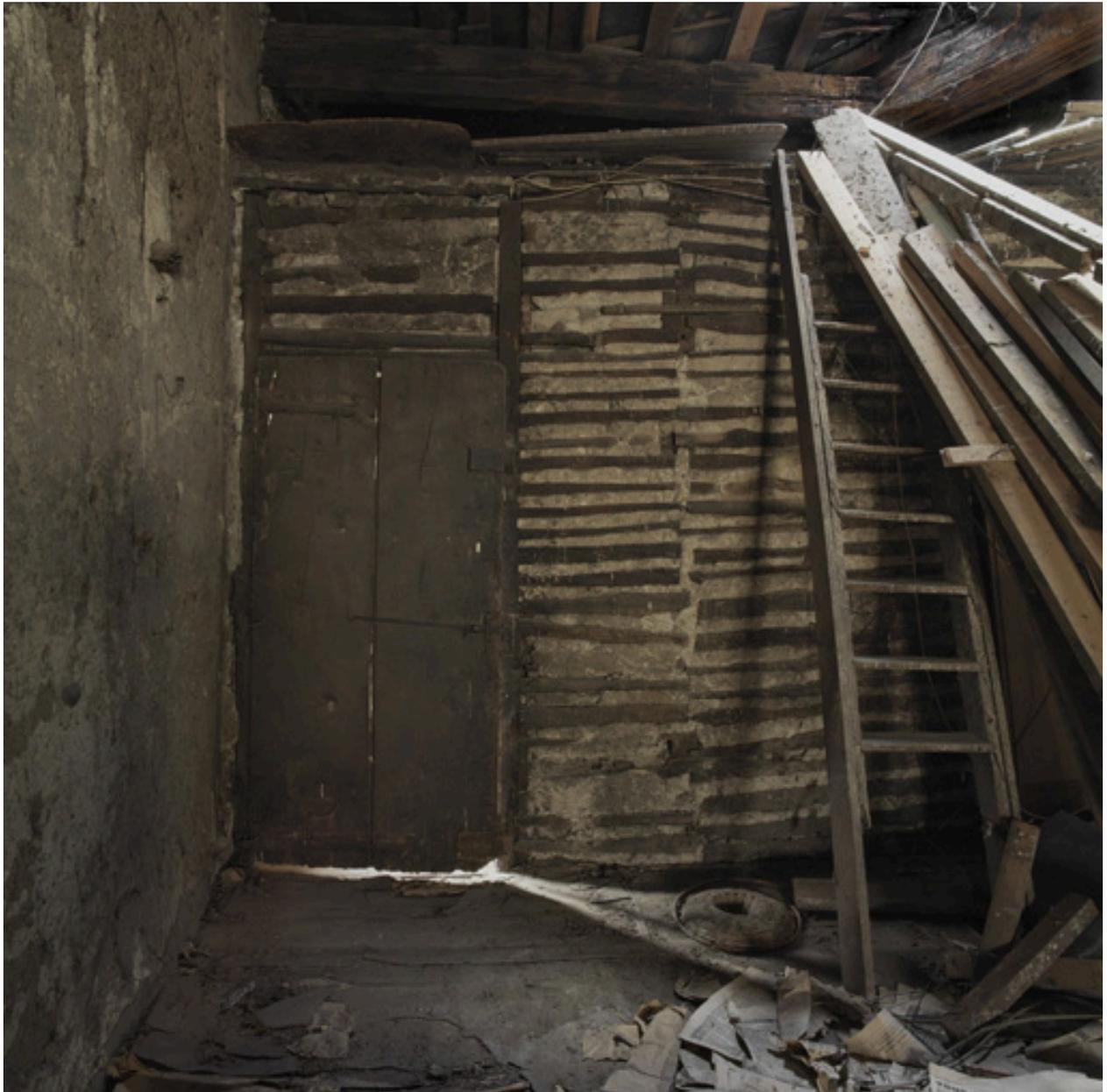
Cloison de l'étage en surcroît réalisée avec un hourdis de torchis.
