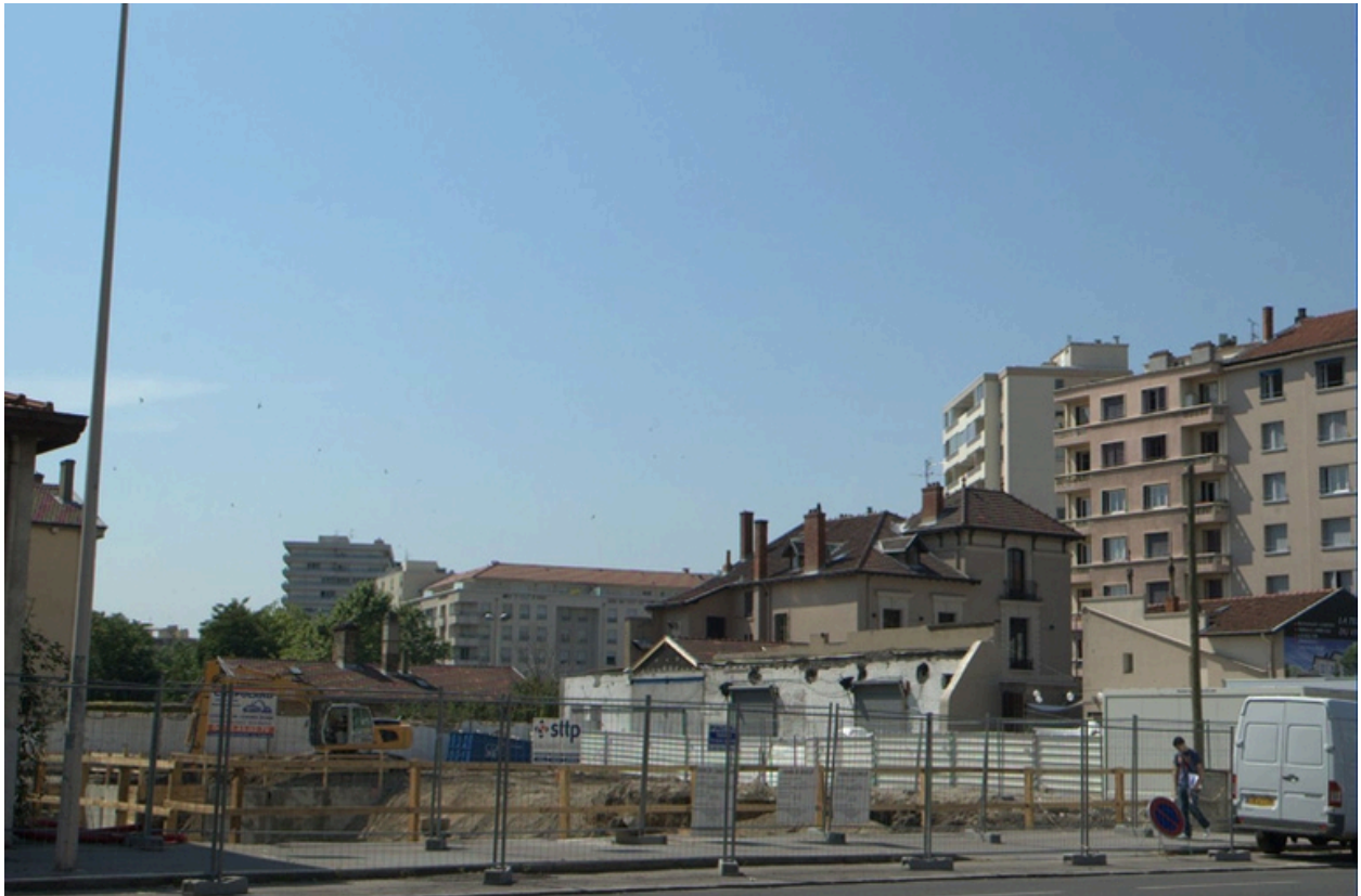
Vue d'ensemble des travaux
