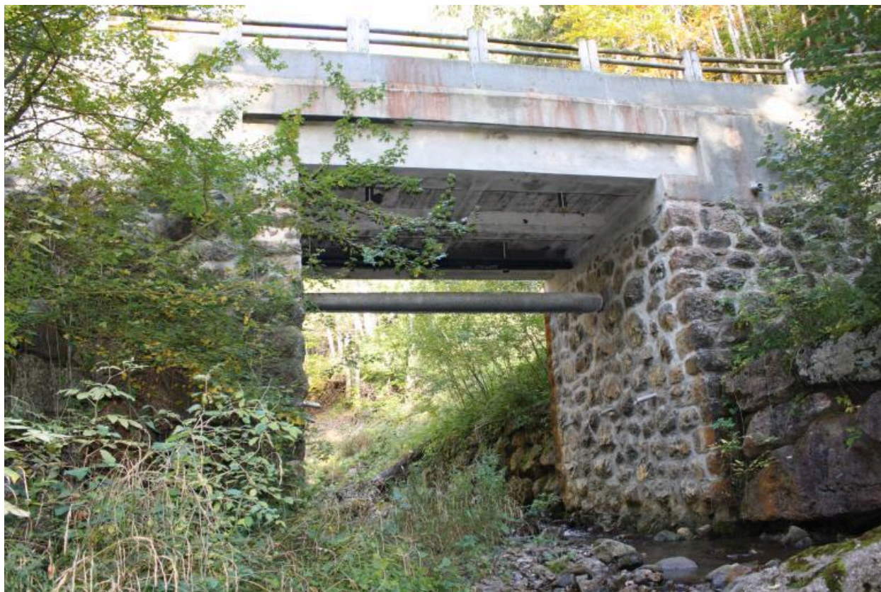
Pont des Onchets, face aval
