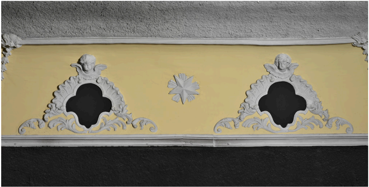
Corniche du plafond, abside, décor de stuc : étoile entre deux angelots.
