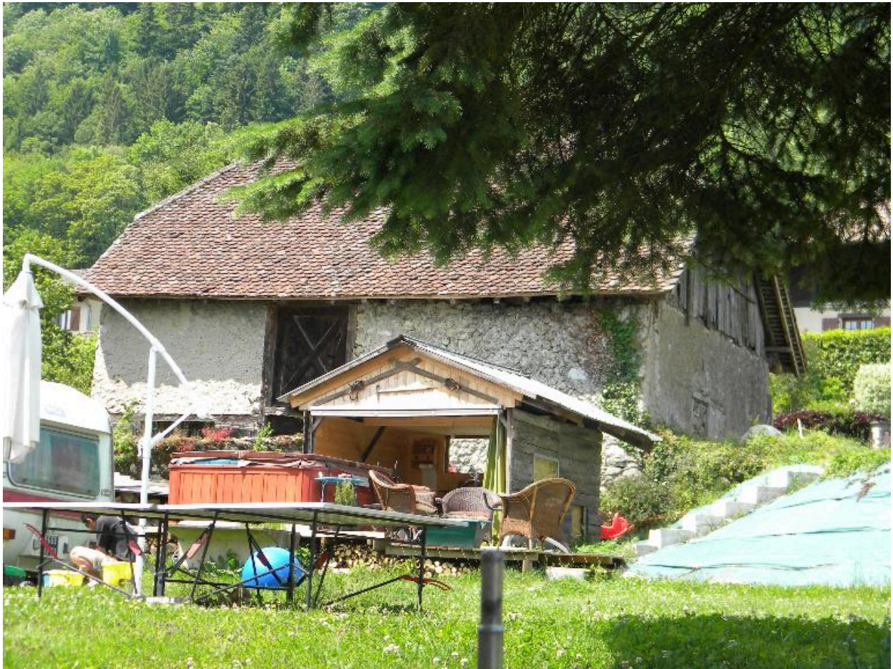
Façade est et pignon nord d'une ancienne forge (2008 B2 383).
