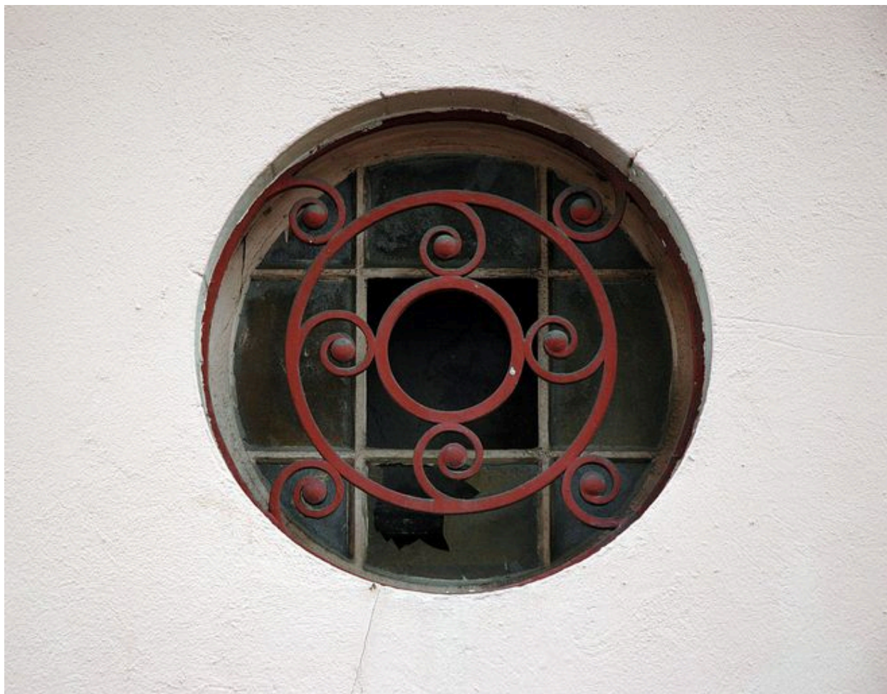
Le pavillon, détail de l'oculus cours Albert-Thomas
