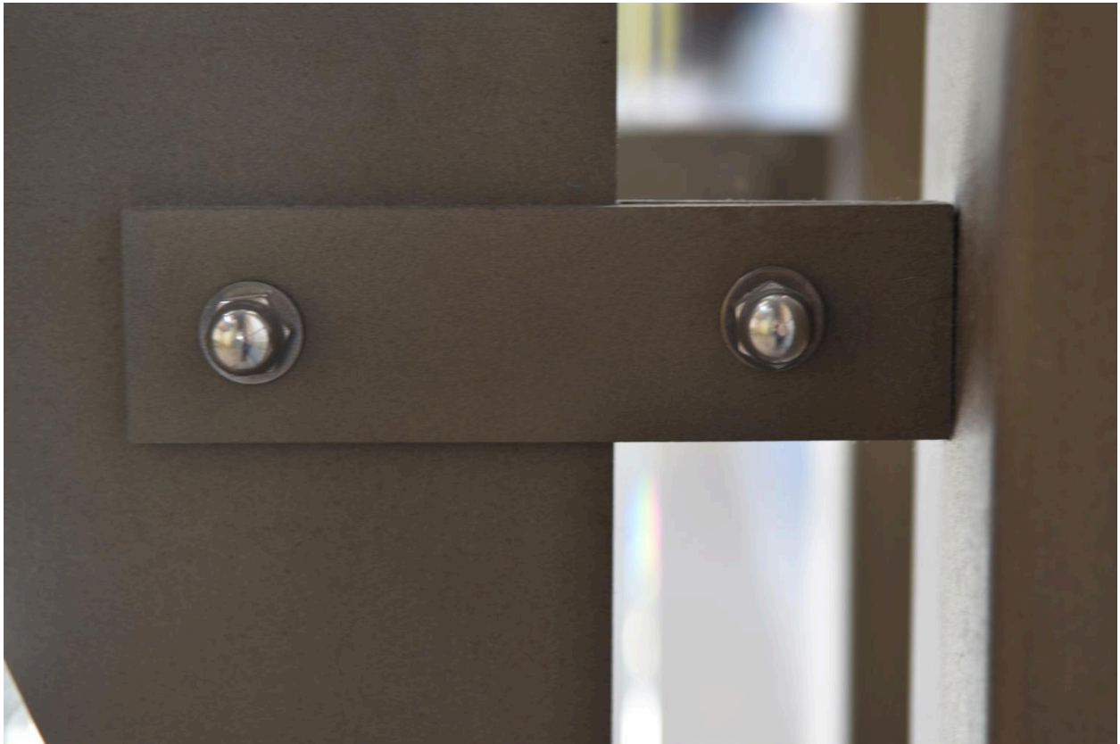
Installation n°5 : détail des pattes de fixation
