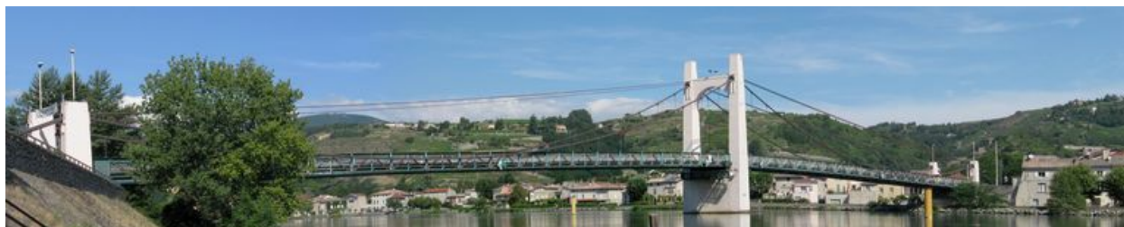
Vue panoramique, face amont (depuis la rive gauche)
