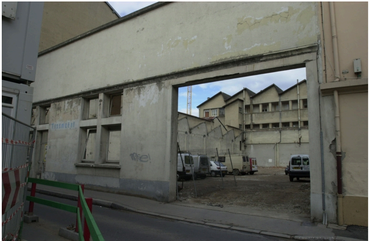
Vue derrière façade sud
