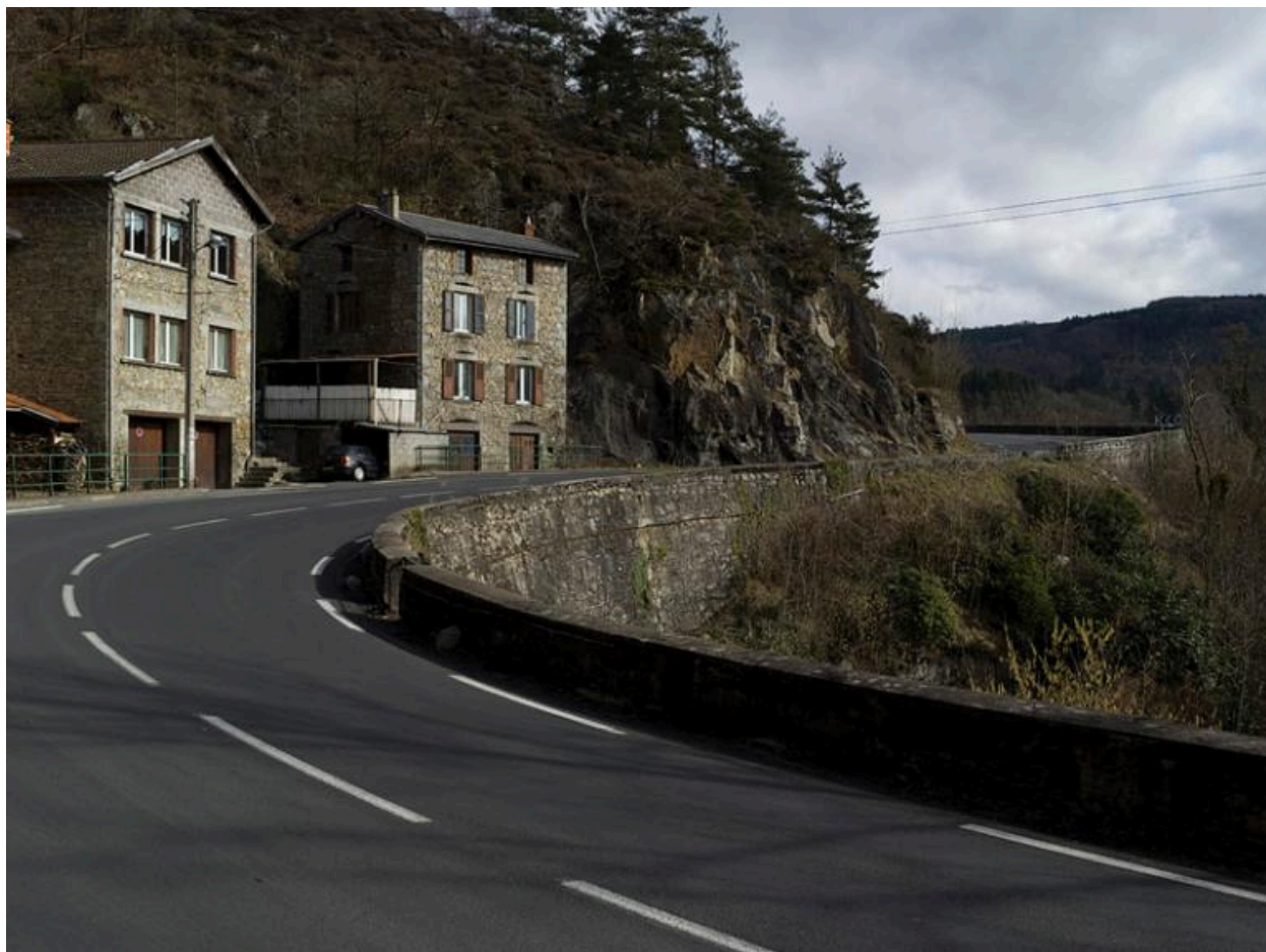
Le lieu-dit la Roche Noire, en bordure de la route de Lyon.
