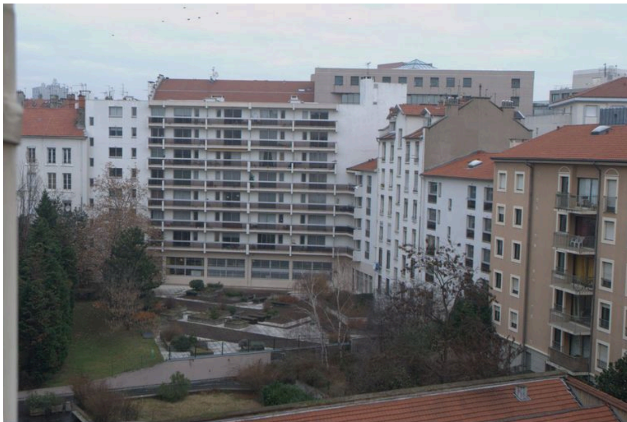
Elévations postérieures depuis le sud-ouest
