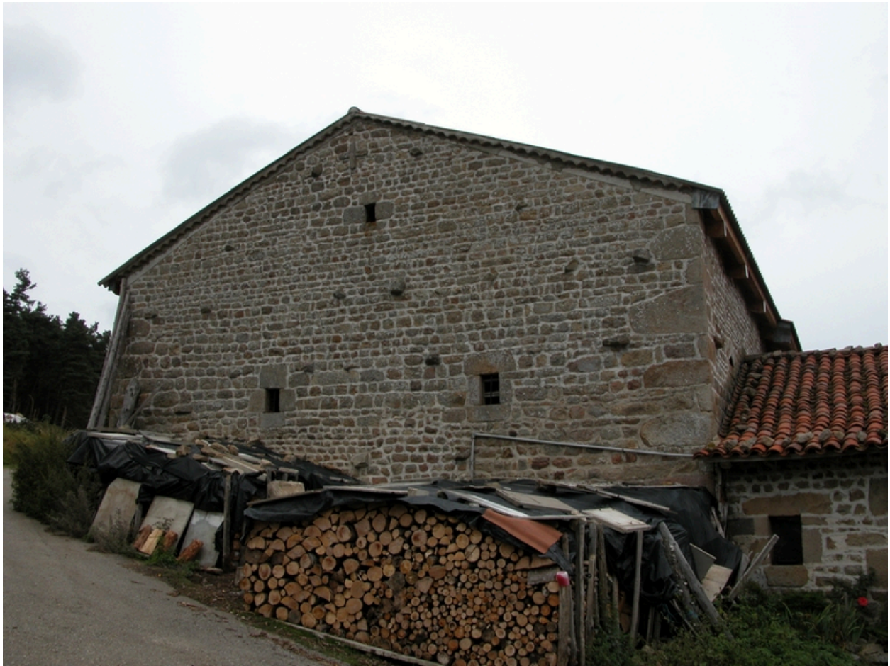
Mur pignon sud de la grange-étable.
