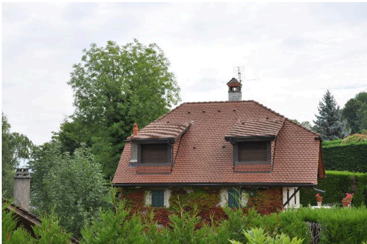
Vue du toit à deux pans avec demi-croupe sur chaque mur pignon du bâtiment du moulin
