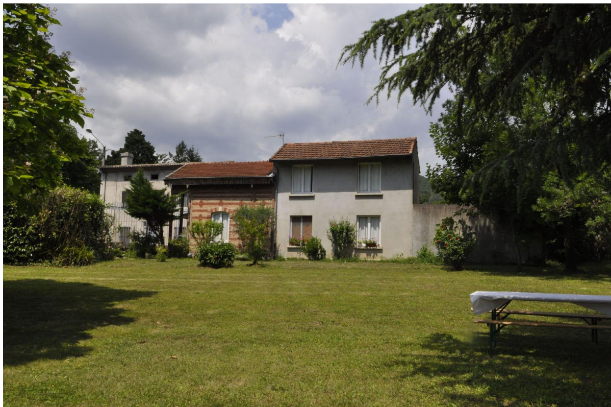
Vue d'extérieur du site
