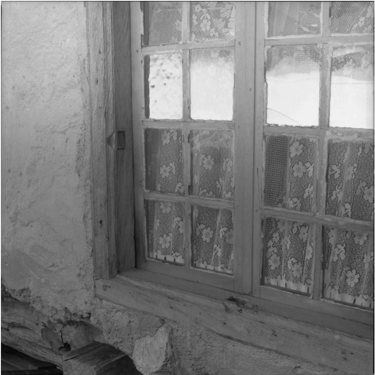
Logis, détail de l'encadrement de la baie à l'étage, trace de croisée en bois.
