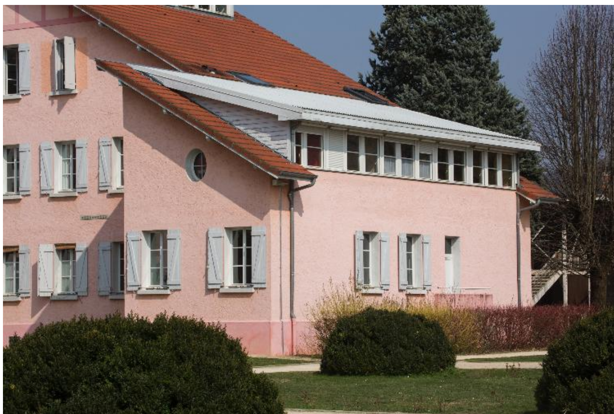
Bât. A : aile est vue depuis le sud
