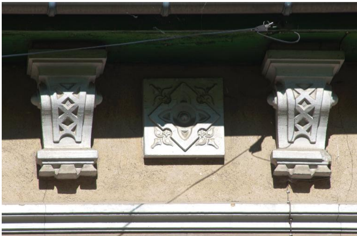
Détail des modillons et des carreaux de béton moulé
