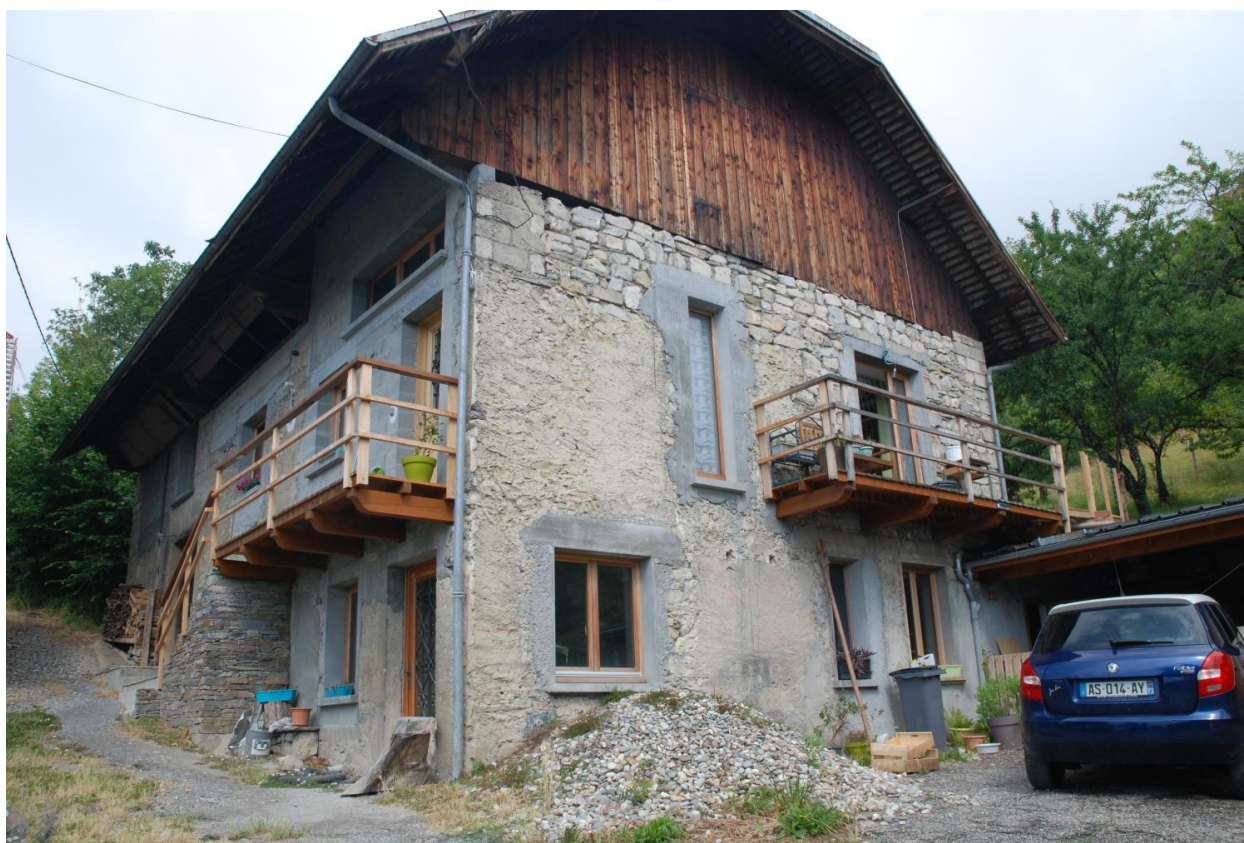
[Partie sud] Ferme à juxtaposition, en cours de rénovation (2018 YK 89).
