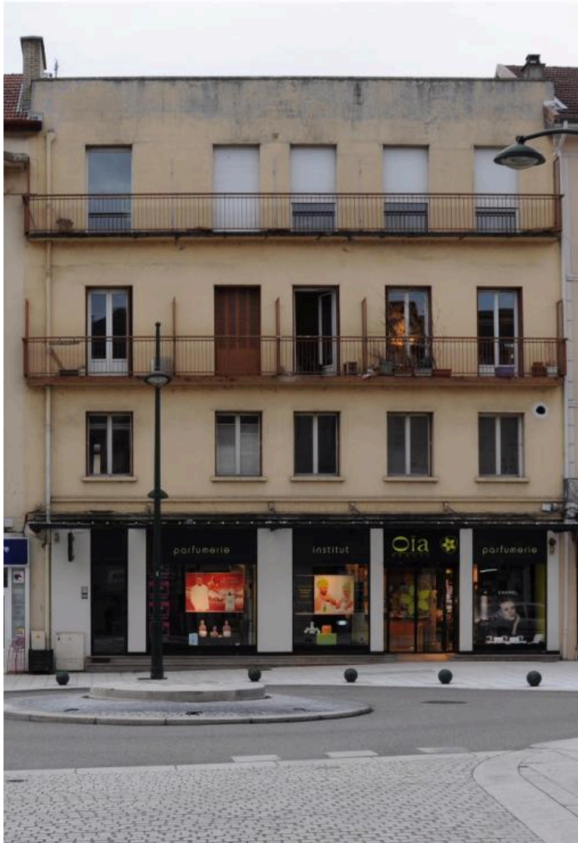
Elévation principale sur la rue de Genève
